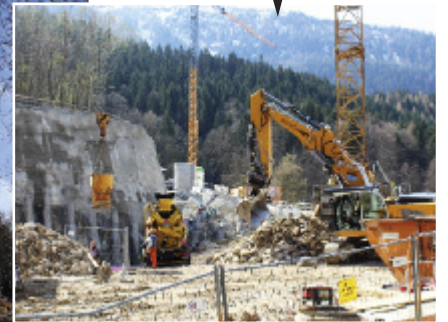
Mai: Bodenplatte / Fundamente im Erdgeschoss
