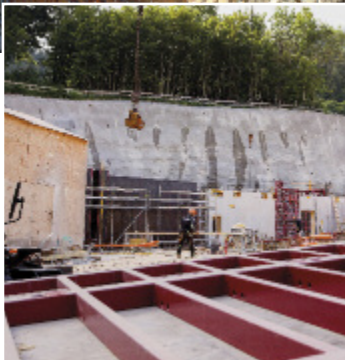
Juni / Juli: Betonierarbeiten der Außenwände des Untergeschosses
