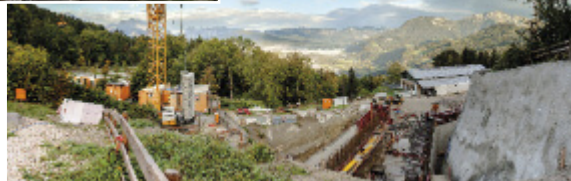
September: Betonage des Vortragsaals im Erdgeschoss
