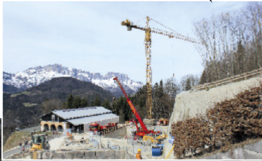
April: Aufstellen Baustellenkran und erste Bauarbeiten im Untergeschoss
