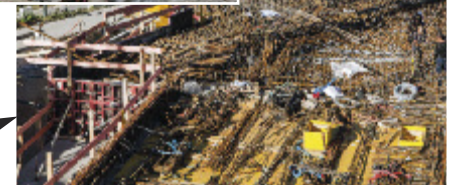
November: Bewehrungsarbeiten der Erdgeschossdecke über Vortragsaal und Foyer
